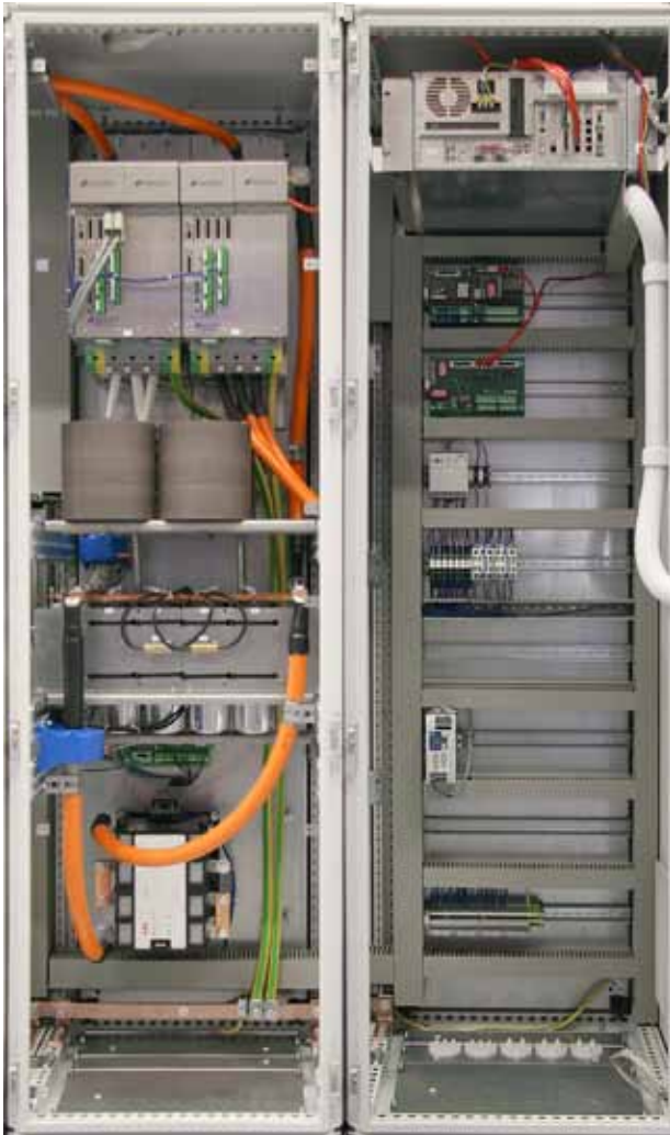
Ein Blick in die DC-Quelle: die VECTODRIVE® Umrichter (links oben) und VECTONUM® V8 Steuerung (rechts oben)
